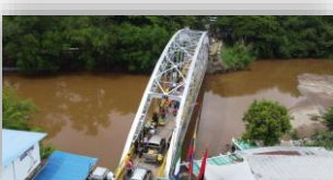
Puente Unión En Puerto Santander
