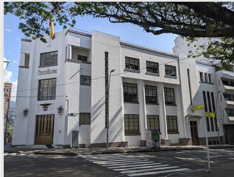
Sede Dirección Seccional de Impuestos y Aduanas de Ibagué Carrera 3 No. 9 – 01 Esq. Edificio Nacional – Ibagué Tolima
